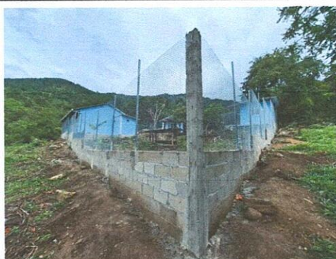
Foto 3: Mejoramiento de muro perimetral, parte de atrás del establecimiento.
