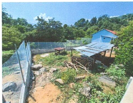
Foto 4: Mejoramiento de muro perimetral interior del establecimiento.
