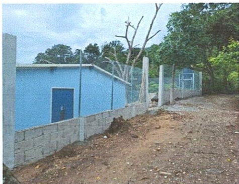
Foto 1: Mejoramiento de muro preimetral para el resguardo de los estudiantes.
